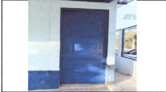
FOTO 2: MANTENIMIENTO A PUERTAS EN MODULO DE AULA
