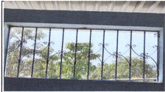
FOTO 4 Fabricación e instalación de balcon de metal en modulo aula 1
