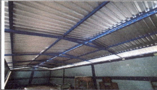
FOTO 1: Sustitución de lámina, por lámina troquelada aluzinc calibre 26 / sustitución de estructura de madera por metal en modulo de aula 1 y 2.
