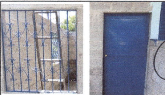
FOTO 3: Fabricación e instalación de puerta de metal en aula 2 / Mantenimiento de balcon de metal en modulo de aula
