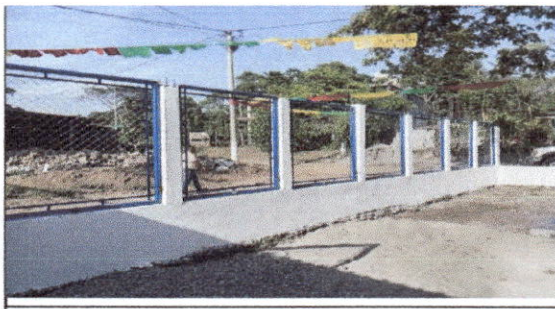
FOTO 6: Reparación de tubo hg y malla galvanizada modulo patio
