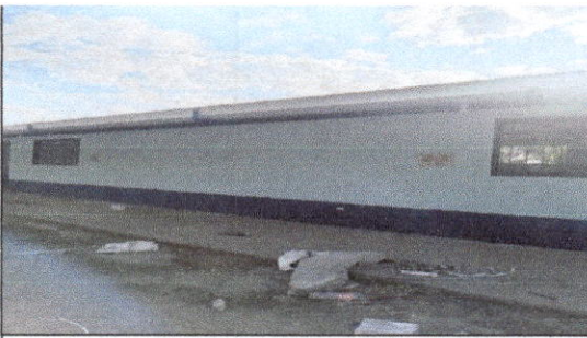
FOTO 5: SUSTITUCION DE CANAL DE METAL ALUZINC CALIBRE 26 MODULO DE AULA 1 Y 2
